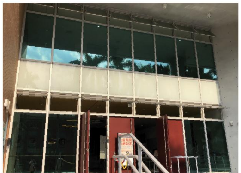
台大新建大樓採用大範圍玻璃結構，隔熱玻璃產生明顯鏡像反射，成為野鳥窗殺風險區。(攝／林志怡)
