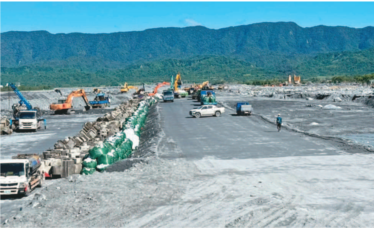
花蓮光復馬太鞍溪右岸堤防被洪水沖破逾二公里，水利署調度人員機具加緊搶修，今天午前完成第一階段土堤，阻擋溪水上漲時進入市區。圖／水利署提供
