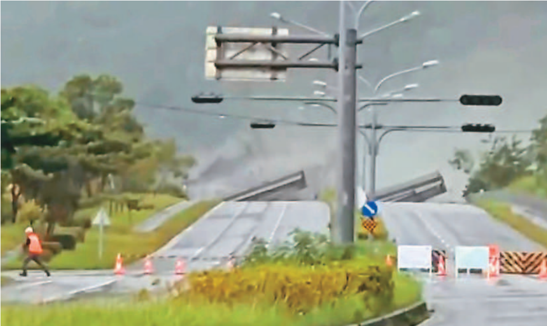
▲樺加沙颱風昨天造成花蓮馬太鞍溪上游堰塞湖溢流，泥水沖毀馬太鞍溪橋的瞬間，一旁監視的工程人員趕緊閃避。 圖／民眾提供
