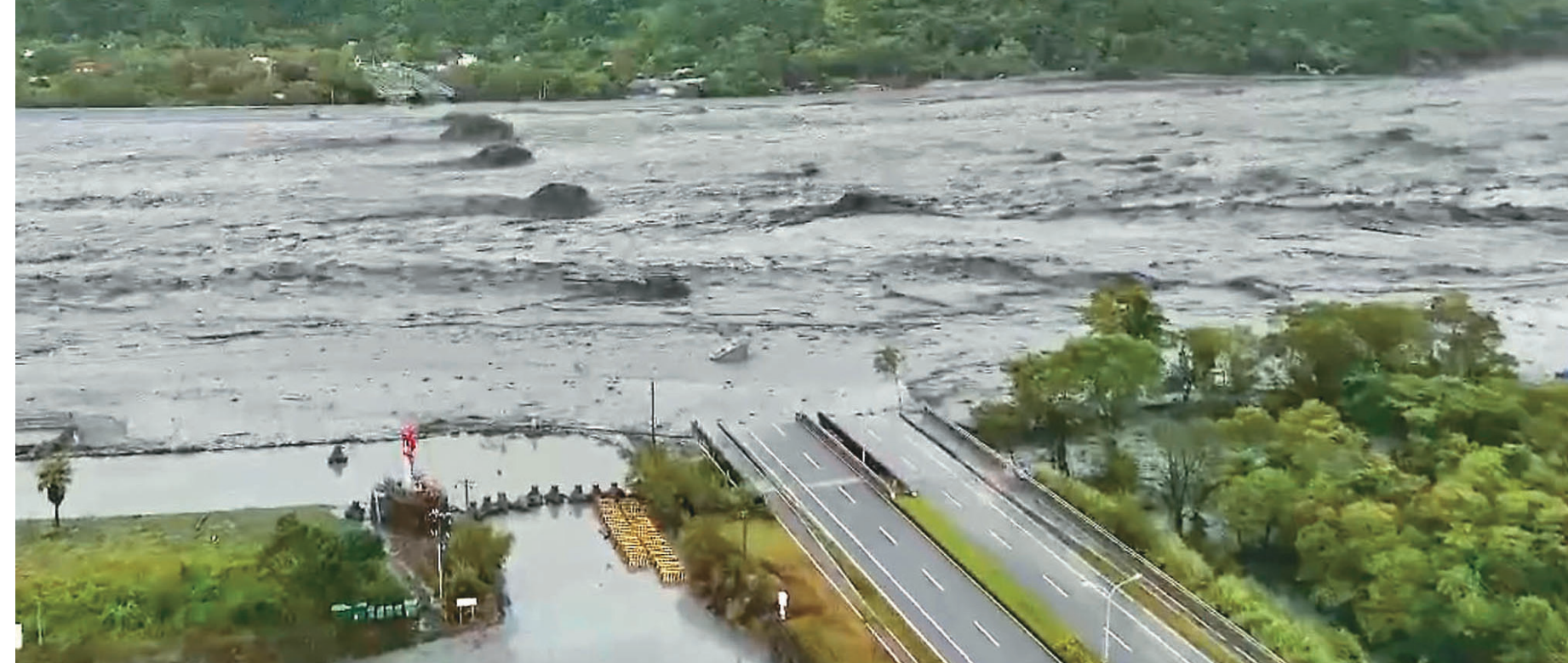
▲馬太鞍溪颶風昨天帶來的大豪雨造成花蓮馬太鞍溪上游堰塞湖溢流，大量泥水沖毀馬太鞍溪橋，下午更直接淹進光復市區。圖／東穩通運公司提供
