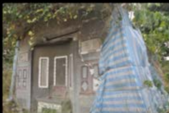
陳氏諸宗親瑤臺墓室牆面崩塌， 蓋上了一層帆布。 (攝影/郭伶妤)
